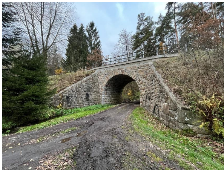
Obrázek 15 – Klenbový most (trať 212, Ostrov u Ledče nad Sázavou)
