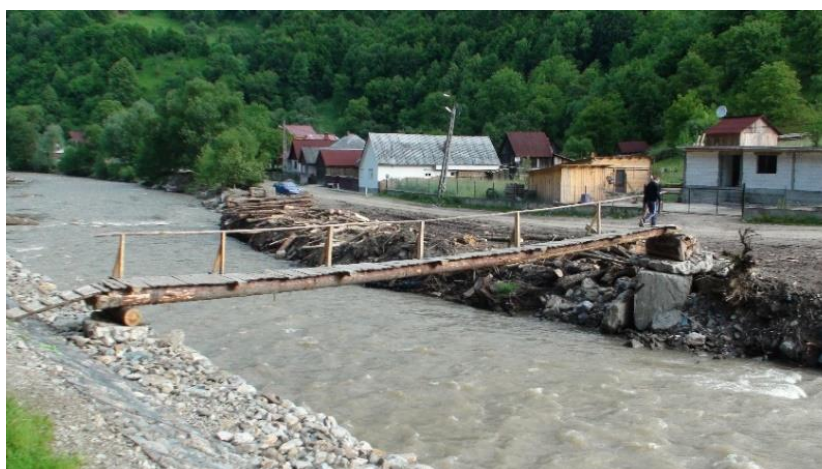
Obrázek 14 – Jednoduchá lávka působící jako prostý nosník (Vișeu de Sus, Rumunsko)
