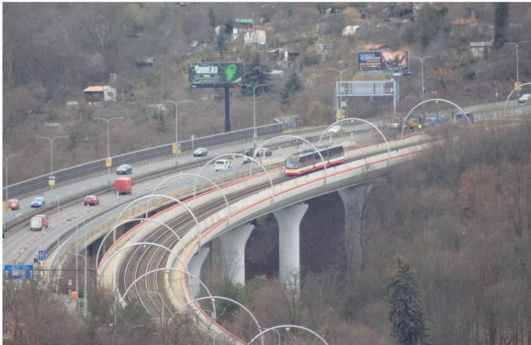
Obrázek 7 – Silniční a tramvajový most přes Růžičkovu rokli
