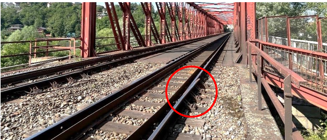
Obrázek 27 – Kolejnicové dilatační zařízení (mokropeský železniční most)
