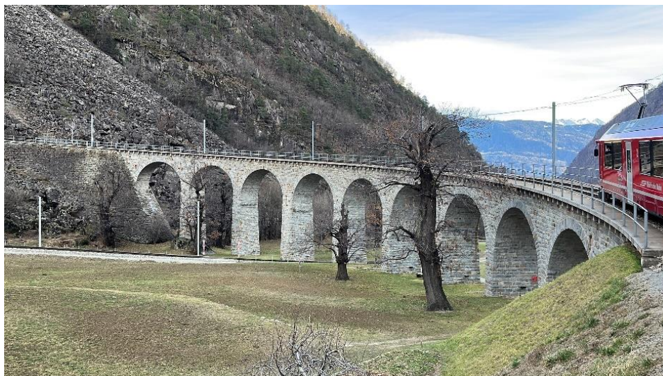
Obrázek 16 – Kruhový viadukt Brusio (Berninabahn, Švýcarsko)
