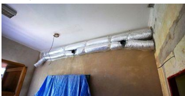
Vzduchotechnika pred zakrytím
