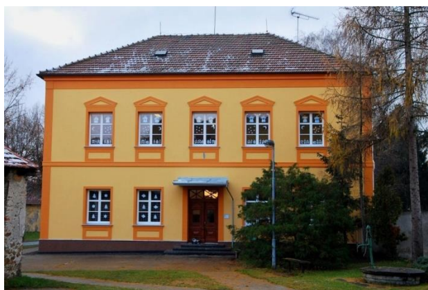
Škola po rekonštrukcii
