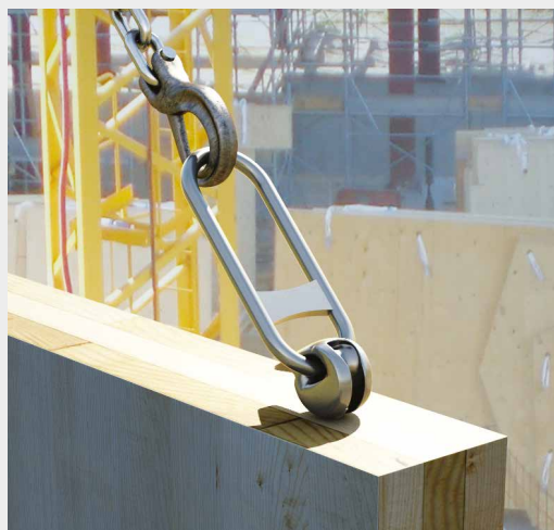
↑ Systém pro zdvih a přesun pomocí háku WASP a vrutu VGS.
