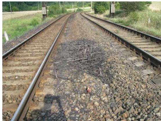
Obr. č. 17: V kolejišti po postřiku
