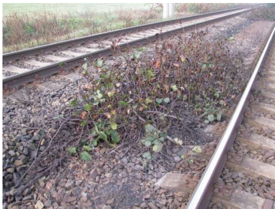
Obr. č. 15: V kolejišti před postřikem
