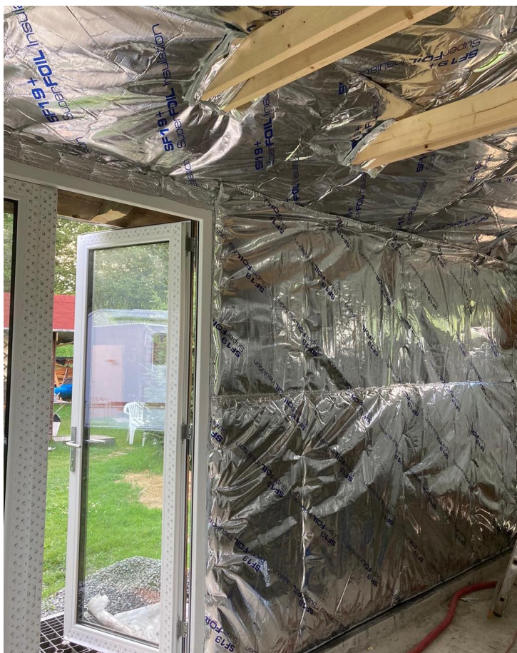
Obrázek 45: Montáž reflexního izolantu v interiéru. Zdroj: interní podklady firmy SuperFOIL.
