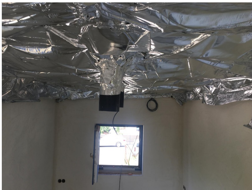
Obrázek 51: Utěsnění kolem prostupů. Zdroj: interní podklady firmy SuperFOIL.
