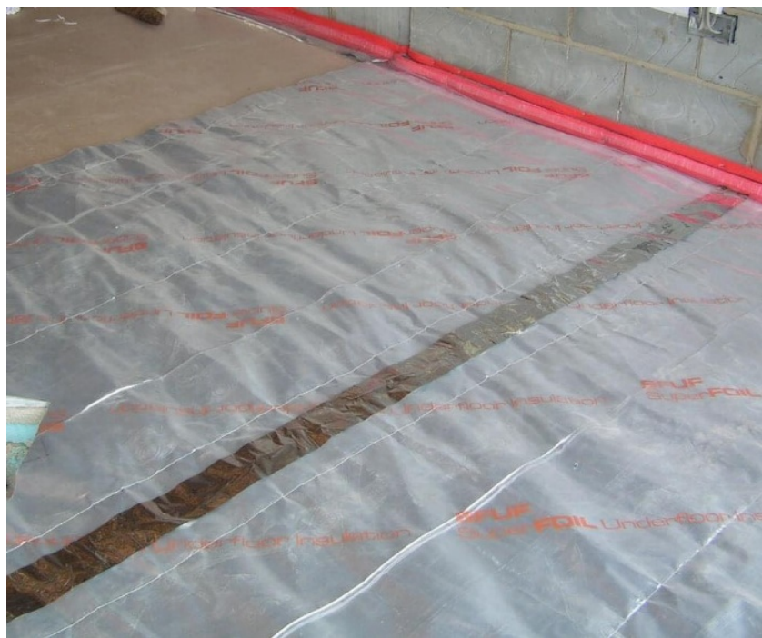
Obrázek 46: Přelepení spojů hliníkovou páskou. Zdroj: interní podklady firmy SuperFOIL.
