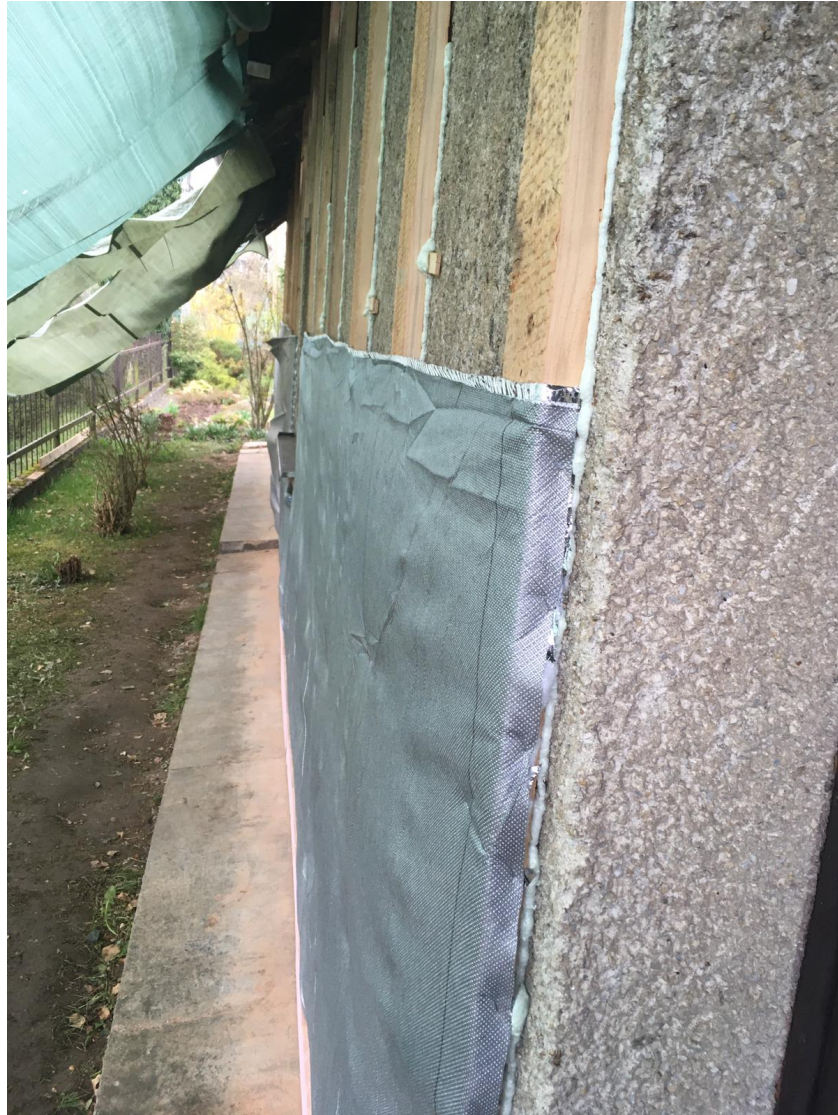
Obrázek 41: Montáž prvního reflexního pásu izolantu. Zdroj: interní podklady firmy SuperFOIL.
