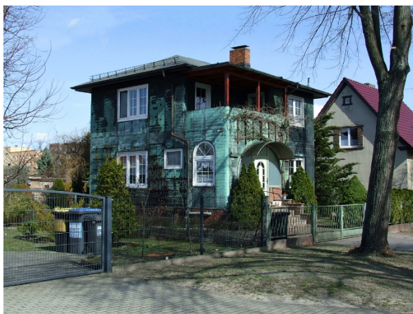
Obrázek 17: Dům od arch. Kraffta a Ing. Forsterema. Zdroj: www.wikipedia.org .
