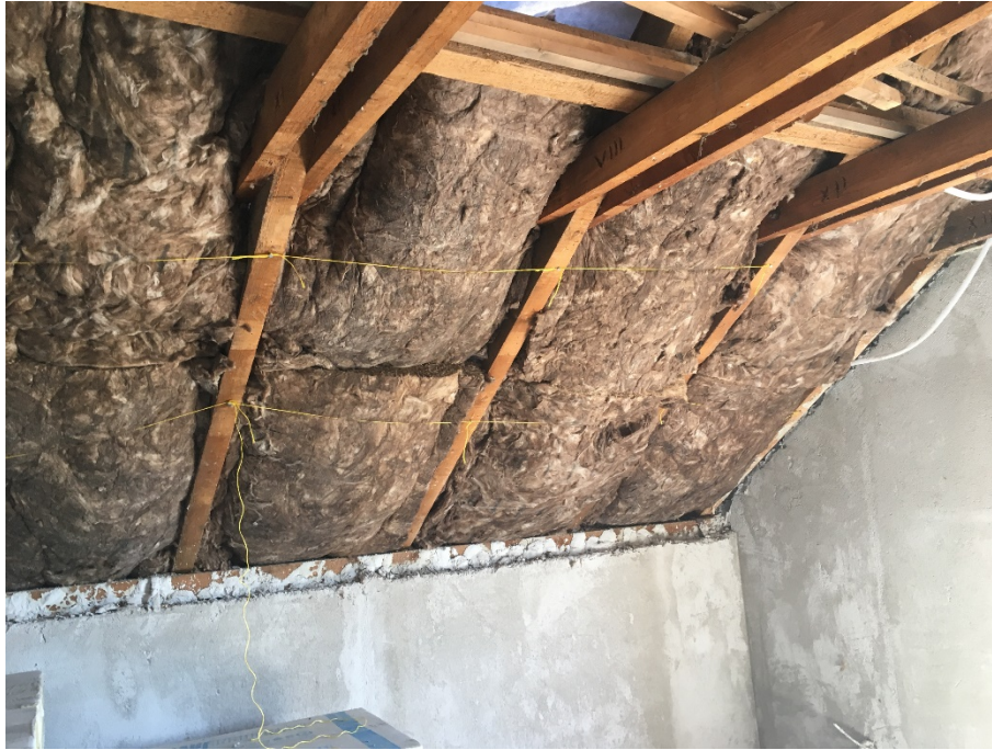
Obrázek 33: Provázání drátku k vytvoření vzduchové mezery. Zdroj: interní podklady firmy SuperFOIL.
