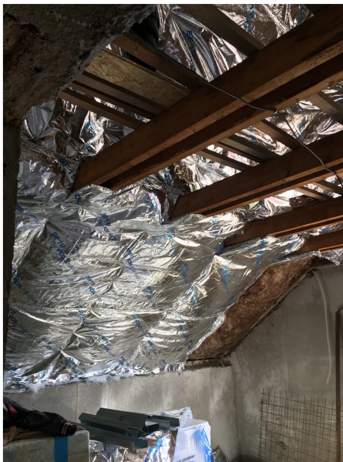
Obrázek 34: Instalace vertikálním směrem. Zdroj: interní podklady firmy SuperFOIL.
