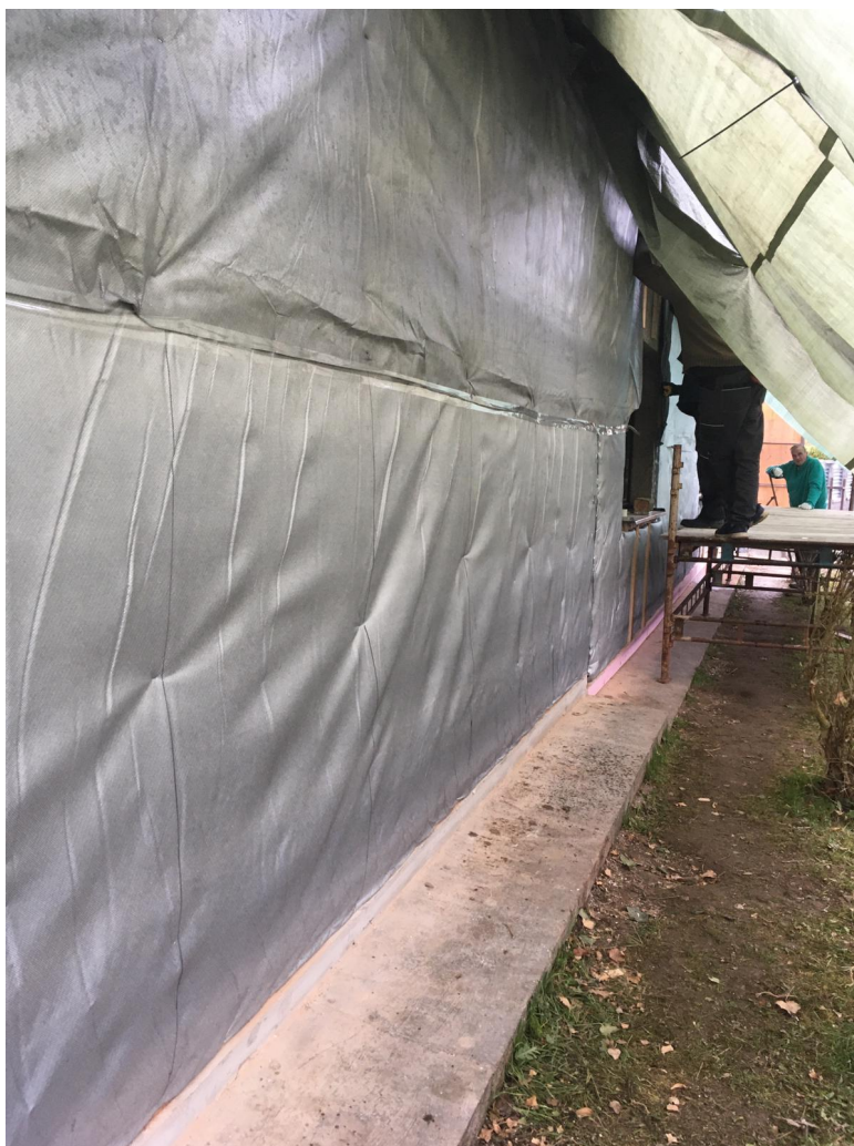
Obrázek 42: Montáž druhého reflexního pásu izolantu Zdroj: interní podklady firmy SuperFOIL.
