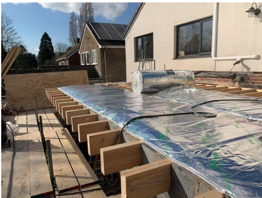
Obrázek 39: Montáž vícevrstvé reflexní izolace. Zdroj: interní podklady firmy SuperFOIL.
