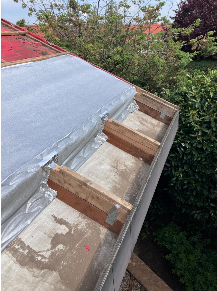
Obrázek 28: Detail utěsnění izolantu za pozednicí z exteriéru. Zdroj: interní podklady firmy SuperFOIL.
