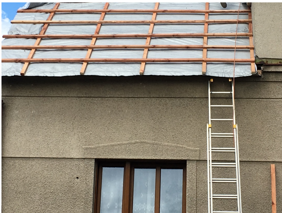
Obrázek 30: Vytvoření vzduchové mezery nad izolantem. Zdroj: interní podklady firmy SuperFOIL
