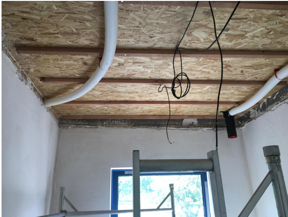
Obrázek 48: Vytvoření vzduchové mezery nad izolantem (pod stropní deskou). Zdroj: interní podklady firmy SuperFOIL.
