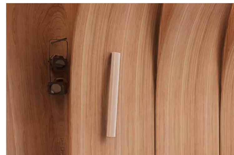
Technické vybavení sálu je umístěno převážně do záhybů vnitřního pláště, aby minimálně vizuálně narušovalo prostor modlitebny.
