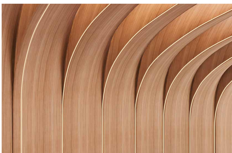
Umělé osvětlení zajišťují led pásy skryté v záhybech vnitřního pláště, které doplňují denní světlo a dotváří požadovanou atmosféru prostoru.
