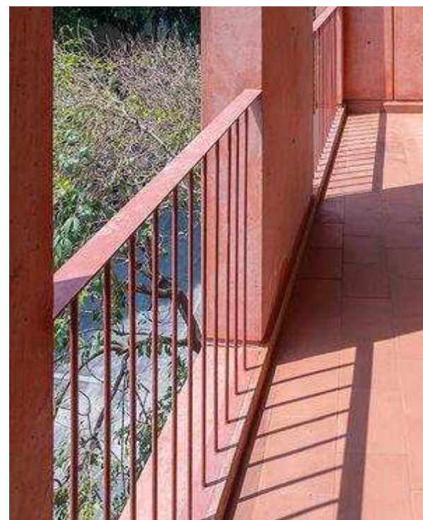
Ocelové zábradlí _ provedení v červeně
