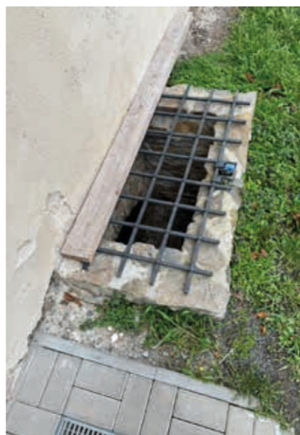
Větrací otvor do sklepa
