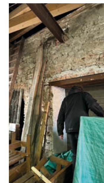
Prostup v interiéru hospodářské budovy
