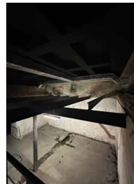
Moderní betonový strop
