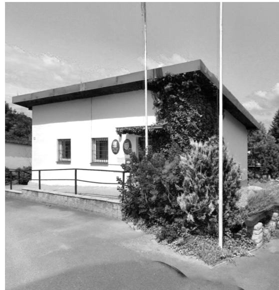
OBECNÍ ÚŘAD NEDOSTATEČNÉ ZÁZEMÍ
