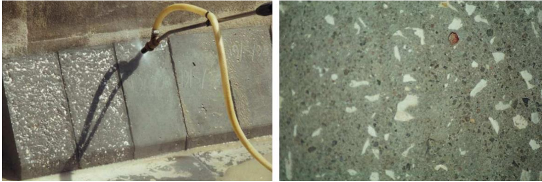
OBR. 8 ÚPRAVA POVRCHU PÍSKOVÁNÍM [15]
