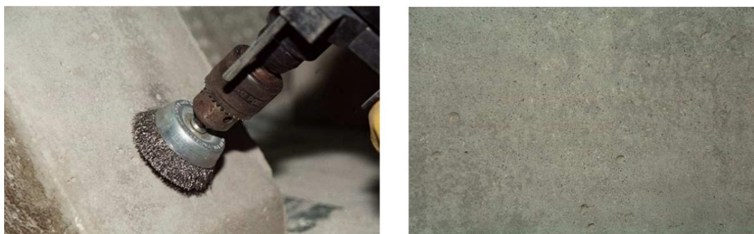
OBR. 6 ÚPRAVA POVRCHU BROUŠENÍM [15]
