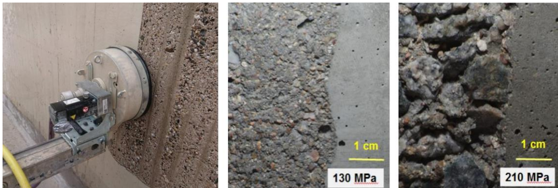
OBR. 9 ÚPRAVA VYSOKOTLAKÝM VODNÍM PAPSREM [16] [17]
