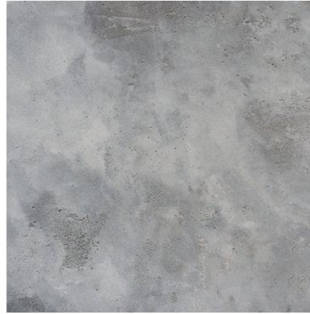
Strop (Hladký pohledový beton)
