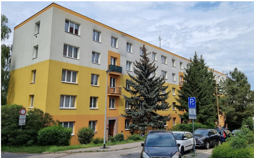
Obr. 2-1 Pohled na jižní a západní fasádu, foto autor
