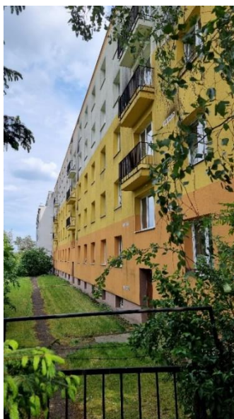
Obr. 2-2 Pohled na severní fasádu, foto autor
