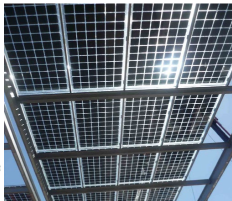
Obr. 37 - Integrace FV modulů VIDURSOLAR v Barceloně, www.globalglassolution.com
