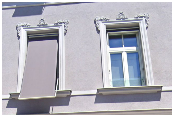
Obr. 56 - detail screenových rolet na Mariahiller Straße 182, zdroj: Google StreetView 2023
