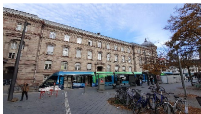
Obr. 52 - budova nádraží Strasbourg-Ville, zdroj: vlastní, 2023
