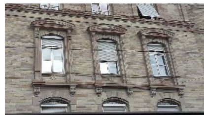
Obr. 54 - osazení kastlíku v obloukovém nadpraží, nádraží Strasbourg-Ville, zdroj: vlastní, 2023
