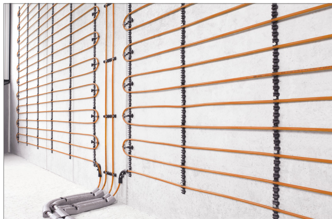
Obr. 5-18 Stěnové vytápění / chlazení - mokrý způsob
