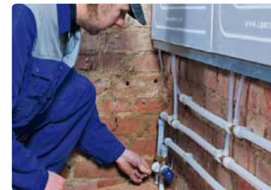
Příklad: Připojení Uponor Renovis panelů nainstalovaných na stěnu. Jednoduchá regulace místnosti prostřednictvím termostatu.
