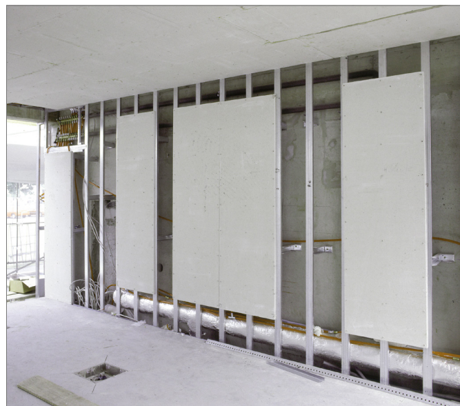
Obr. 5-6 Stěnové desky vytápění / chlazení v suché konstrukci
