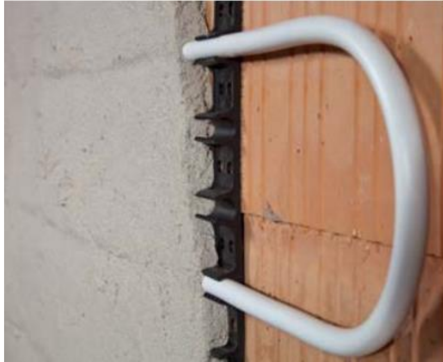
Obr. 26 Mokrý způsob pokládky Kermi [7]
