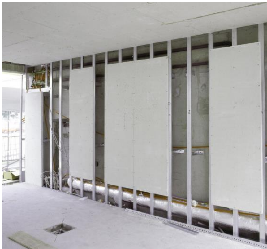
Obr. 5 Stěnové desky v suché konstrukci [5]
