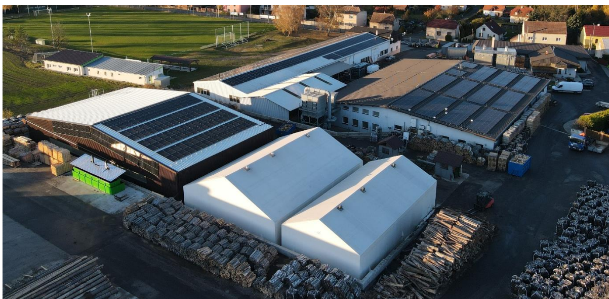
Obrázek 17 Areál podniku PINIE s nainstalovanými fotovoltaickými panely, zdroj vlastní
