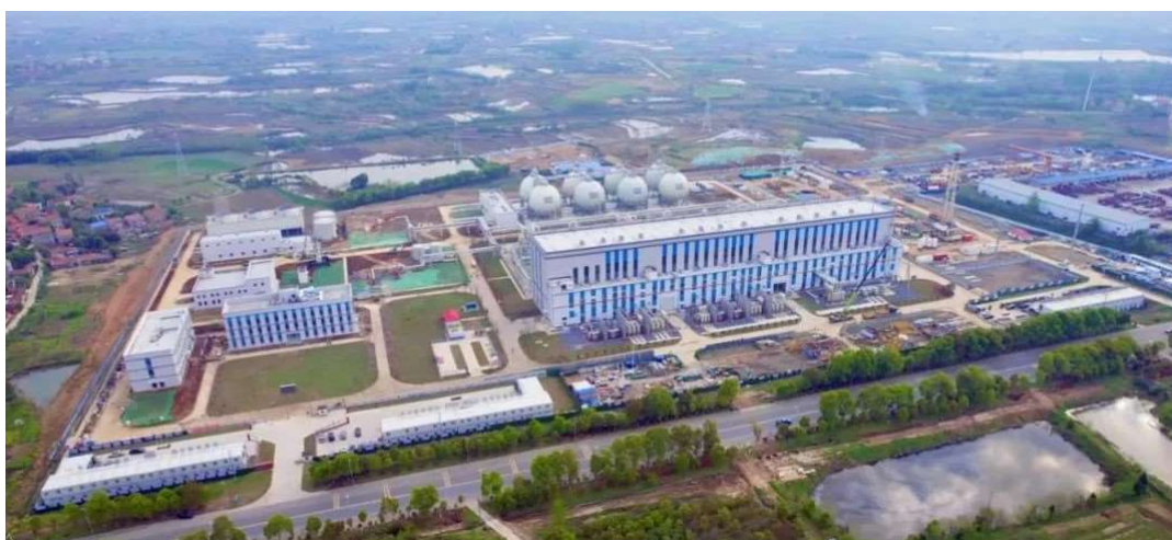
Obrázek 46: Pohled na elektrárnu AA-CAES Hubei Yingcheng, převzato z [50]
