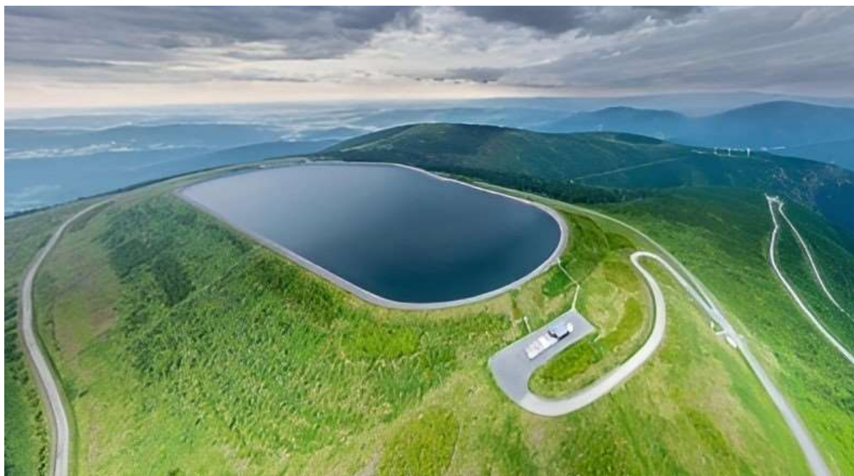
Obrázek 15: Horní nádrž Přečerpávací vodní elektrárny Dlouhé stráně, převzato z [24]
