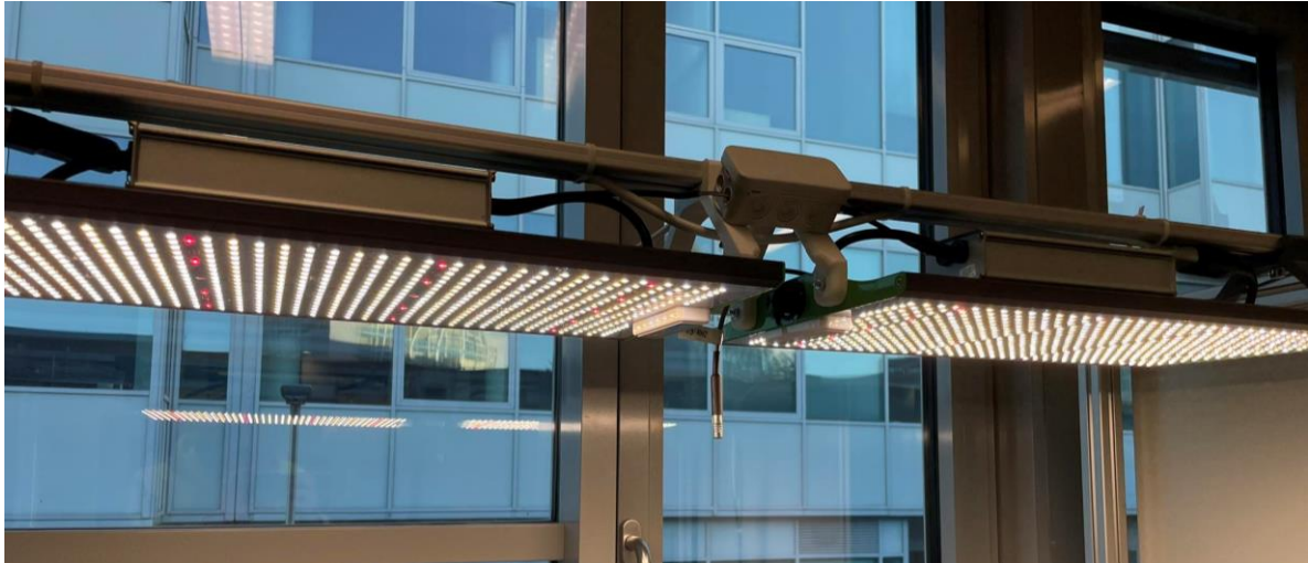
Obrázek 27: Světla značky ViparSpectra. (uprostřed je vidět sonda pro měření teploty a vlhkosti)
