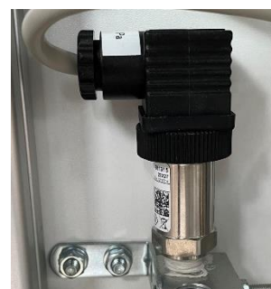
Obrázek 23: Tlakový snímač.
