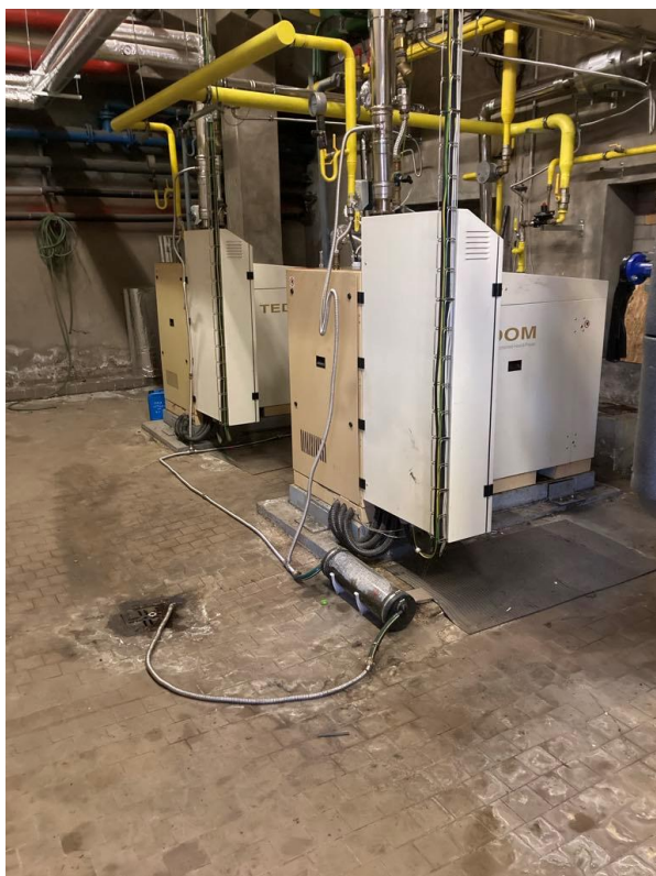
Obrázek 6.2.1 KGJ Tedom v kotelně penzionu
