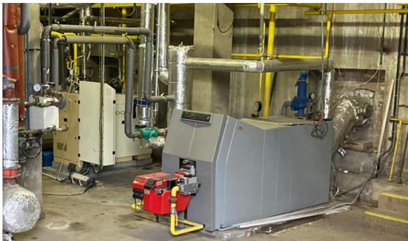
Obrázek 2.1 Plynový kotel a KGJ (vlevo)
