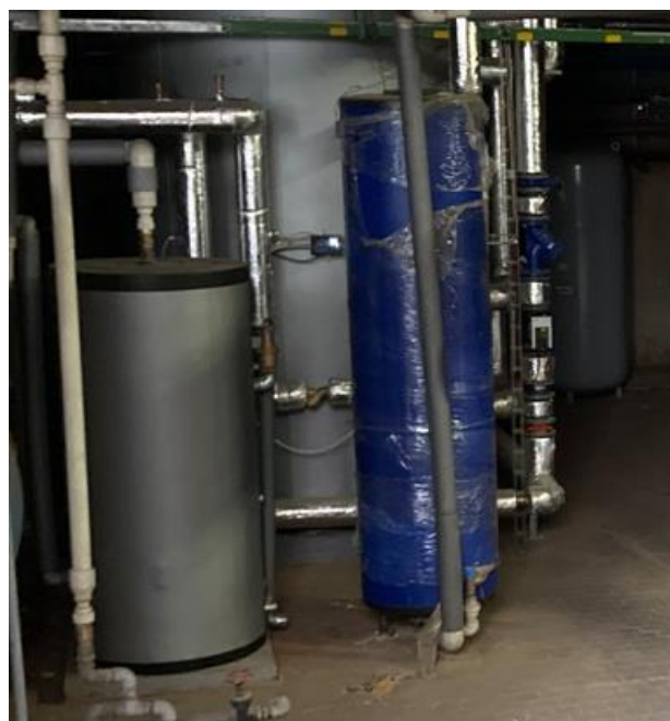
Obrázek 2.1.1 Zásobník TV a rezervní zásobník TV (vpravo)
