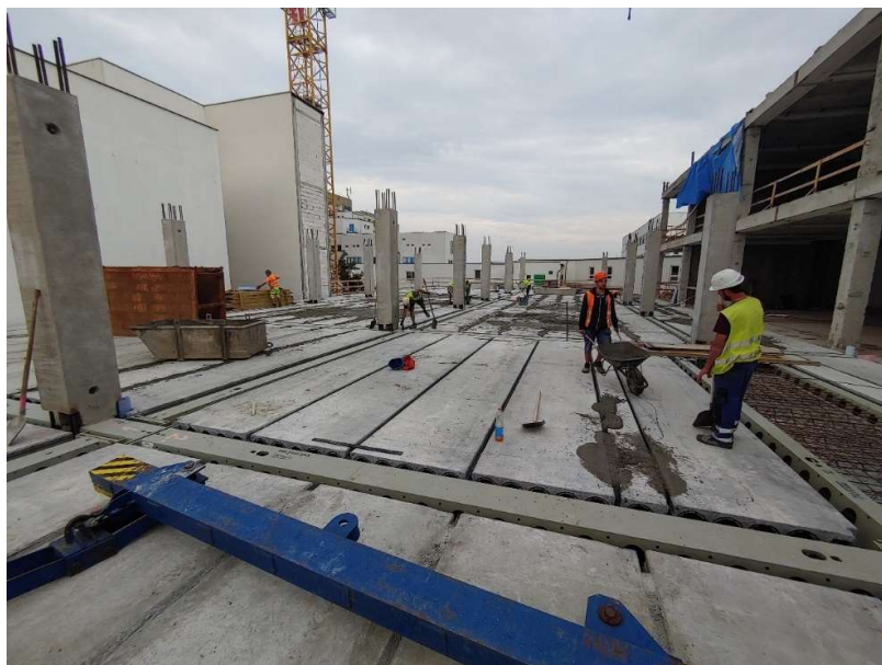
Obrázek 12: Betonování spár mezi prefabrikovanými prvky
