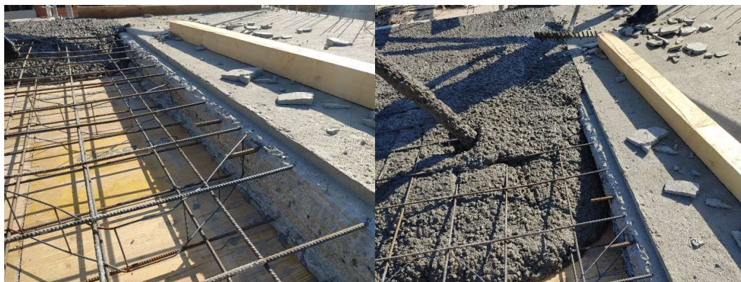
Obrázek 9: Betonovaná pracovní spára stropní desky [12]
