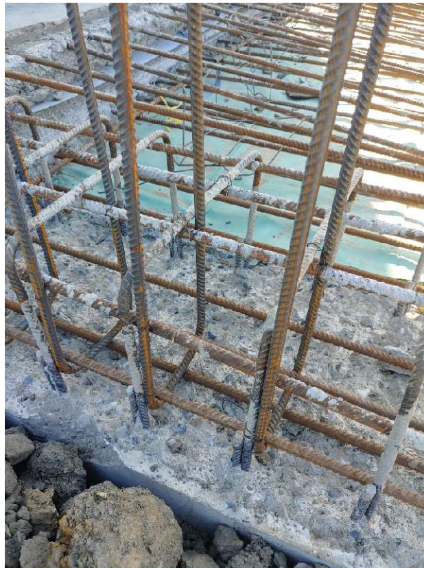
Obrázek 5: Zdrsňený základový pás pneumatickým kladivem, vlastní zpracování
