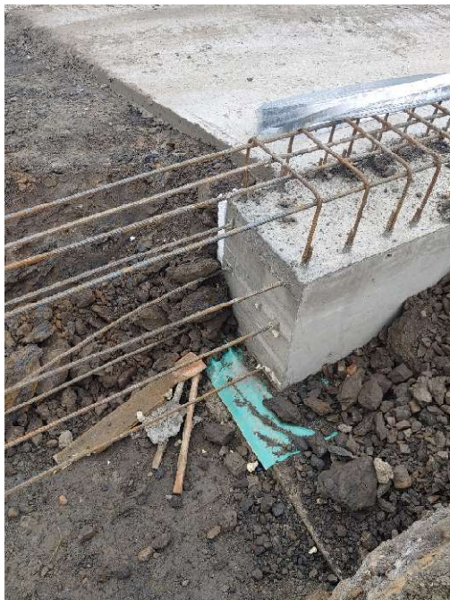
Obrázek 10: Pracovní spára základového pasu [12]
