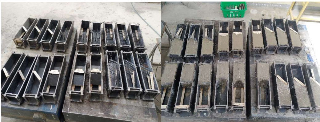
Obrázek 15: Instalované bednění a betonáž první poloviny každého vzorku s pracovní spárou
