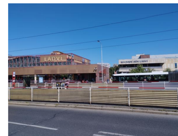
Obrázek 53: Kulturní dům a stanice metra C ze Střelničné ulice
