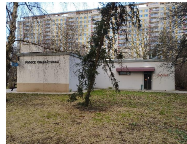
Obrázek 122: Pivnice v bývalé budově klubovny
