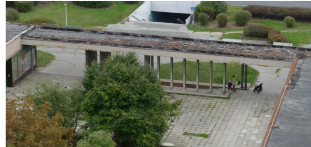
Obrázek 133: Spojovací střechy před demolicí [45]
