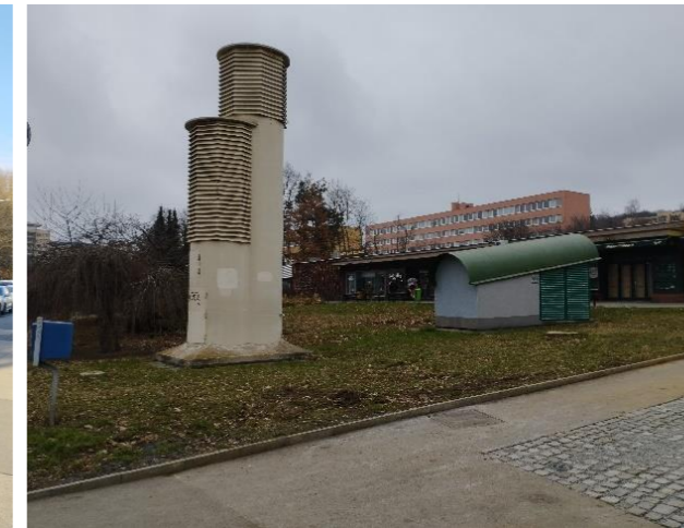
Obrázek 86: Povrchové výduchy z kolektorů
