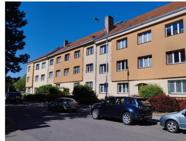
Obrázek 47: Fotografie bytových domů v Davídkově ulici
