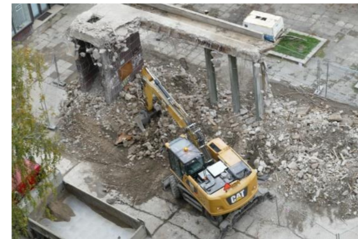
Obrázek 134: Demolice spojovacích střech [45]
