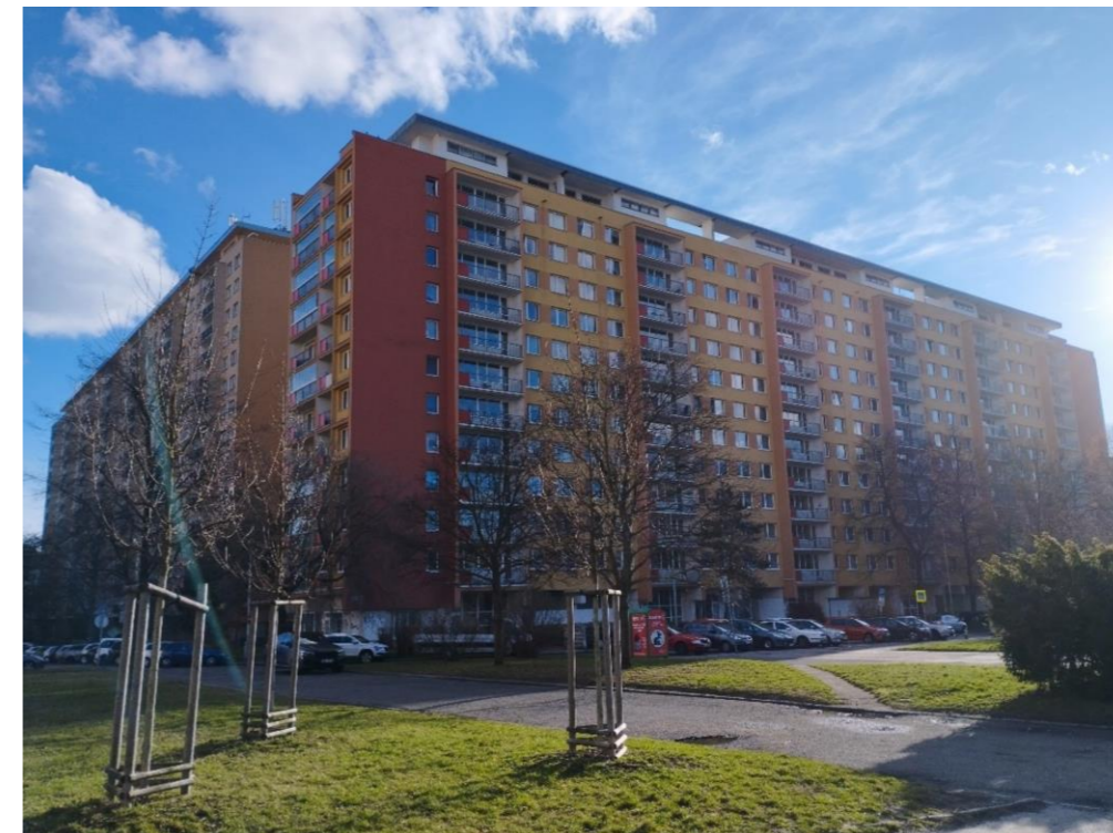
Obrázek 39: Foto deskového domu
