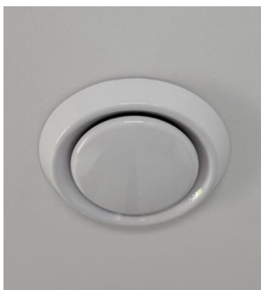
Obrázek 7 Plastový talířový ventil
