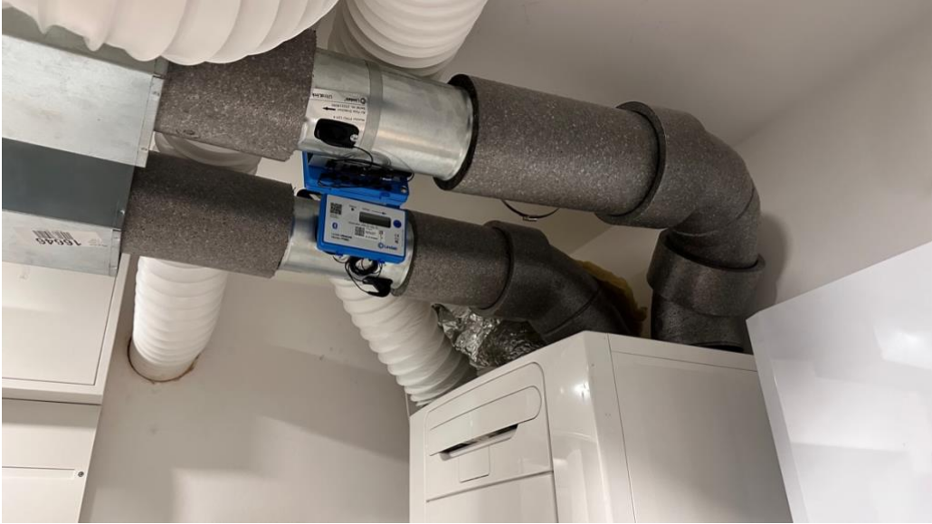
Obrázek 22 Umístění průtokoměrů v EPP potrubí
