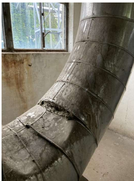
Obr. 11: Stávající stav parovodu umístěného v objektu M101
