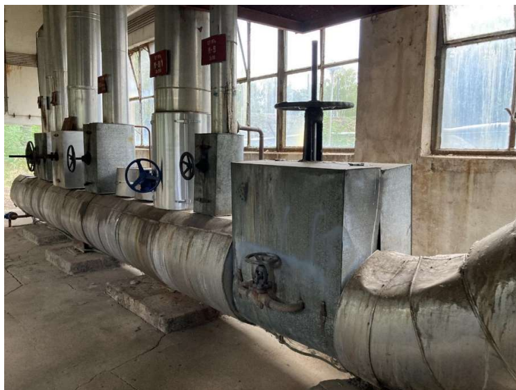
Obr. 9: Parní rozdělovač M101
