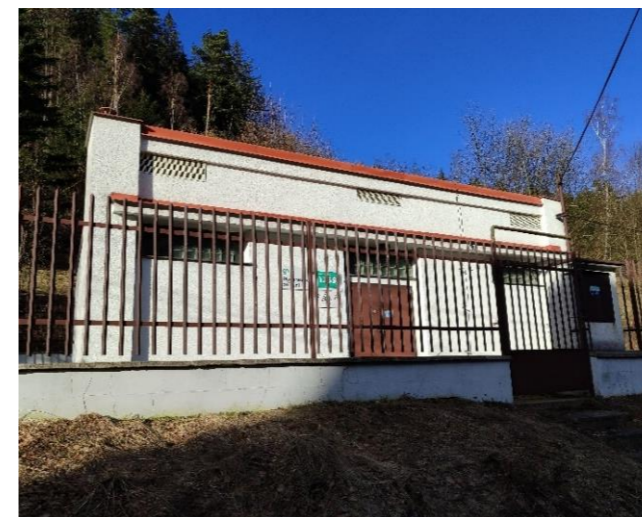
Obr. č. 79: Regulační stanice plynu
