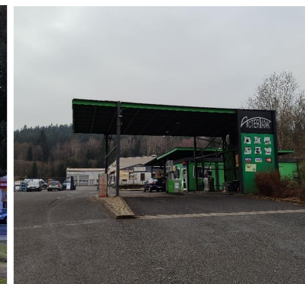
Obr. č. 51: Čerpací stanice u silnice III/28733
