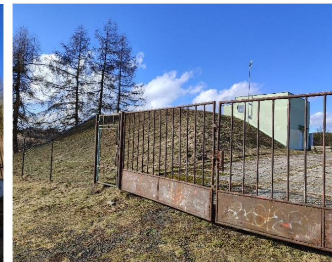
Obr. č. 80: Vodojem v oblasti Horní Vsi
