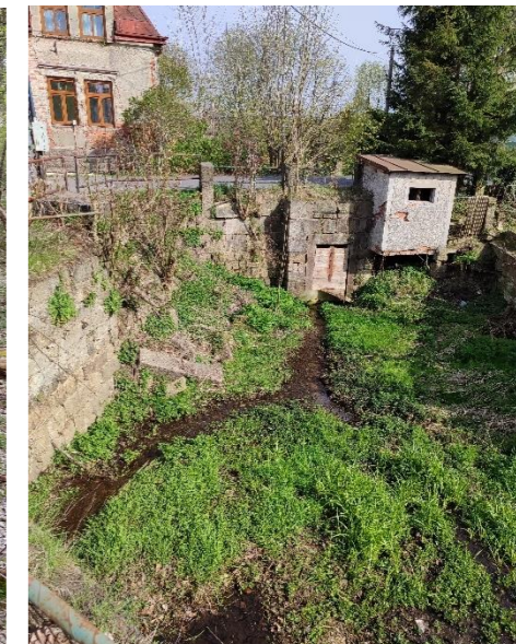
Obr. č. 127: R2 – nádrž pod kostelem
