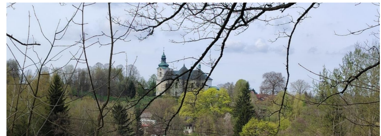
Obr. č. 98: Pohled na kostel
