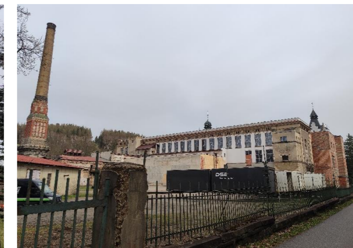
Obr. č. 100: areál továrny včetně komína
