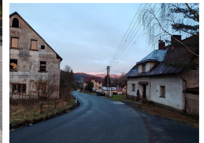
Obr. č. 68: Silnice III/29041
