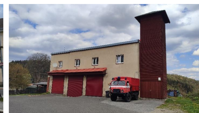
Obr. č. 106: Hasičská zbrojnice
