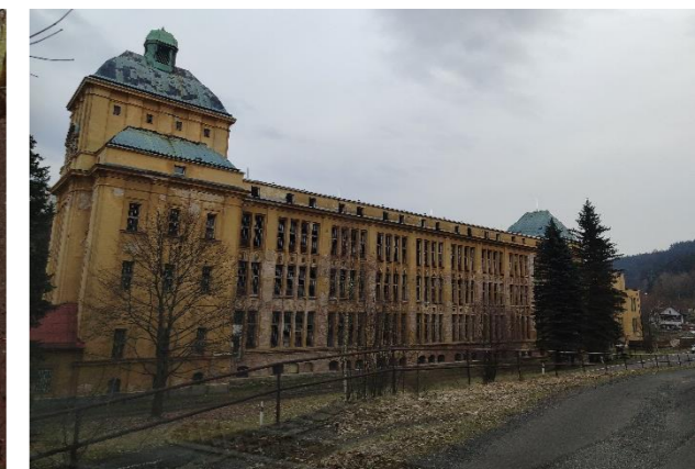
Obr. č. 117: B2 – areál SEBA T na Dolní Smržovce
