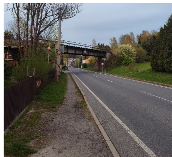
Obr. č. 121: Silnice I/14 v úseku bez chodníku
