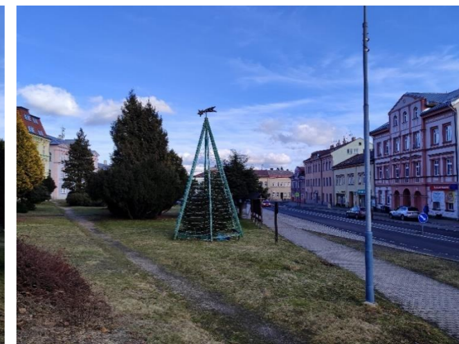
Obr. č. 60: Náměstí se silnicí I/14 a s přilehlou OV
