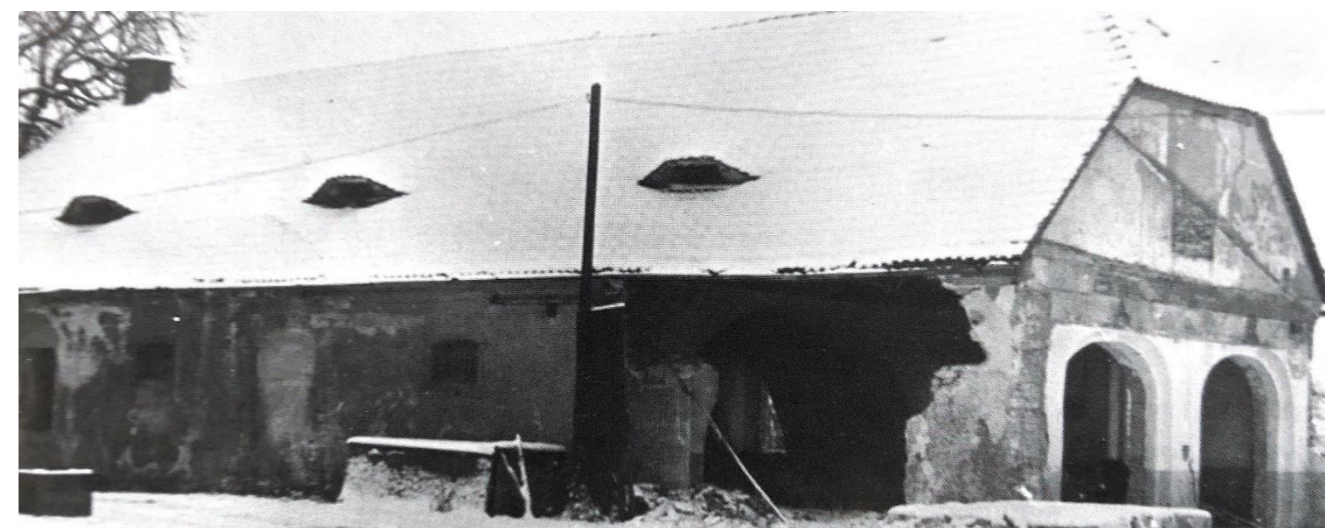
Obrázek 23: Jižní hospodářské křídlo nádvoří zámku krátce před demolicí
