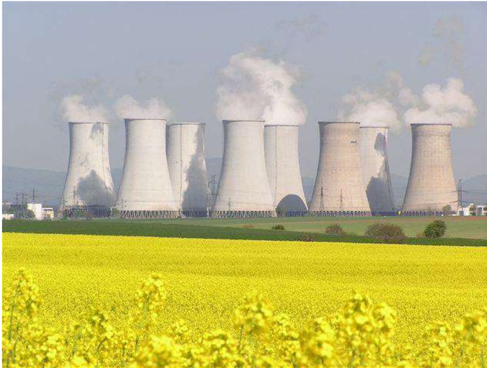
Obrázok 9 Chladiace veže jadrovej elektrárne Jaslovské Bohunice [4]
