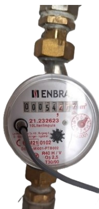
Obr. 26: Bytový vodoměr ENBRA ET I s impulsním výstupem 10 l/impulz
