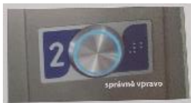
Obrázek 18: Označení tlačítka výtahu Braillovým písmem (26)
