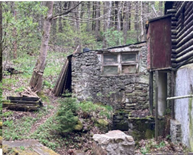
Obr. 26 – Zachovalá část kamenné stavby (foto autorky, 2024)
