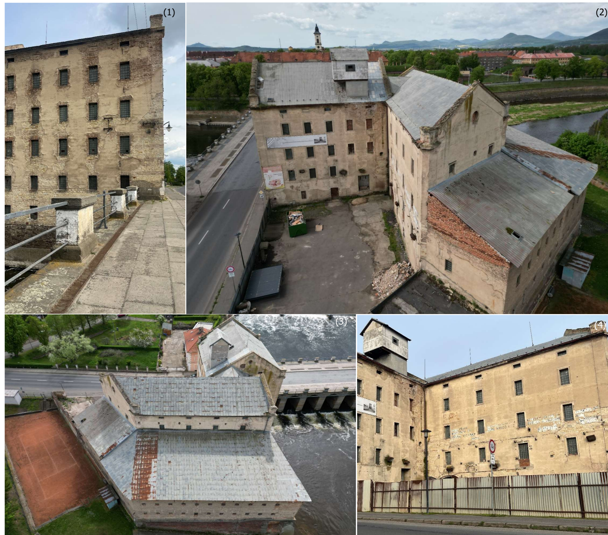
Obrázek 44 Bývalý posádkový pšeničný mlýn: (1) Fasáda budovy západní (2) Východní pohled (3) Severní pohled (4) Jižní pohled
