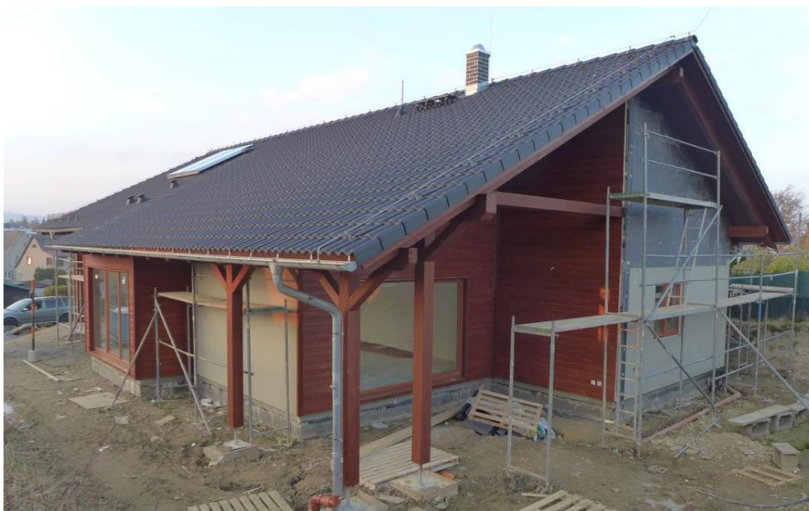
Obr. 31: Fotografie objektu během výstavby [61]
