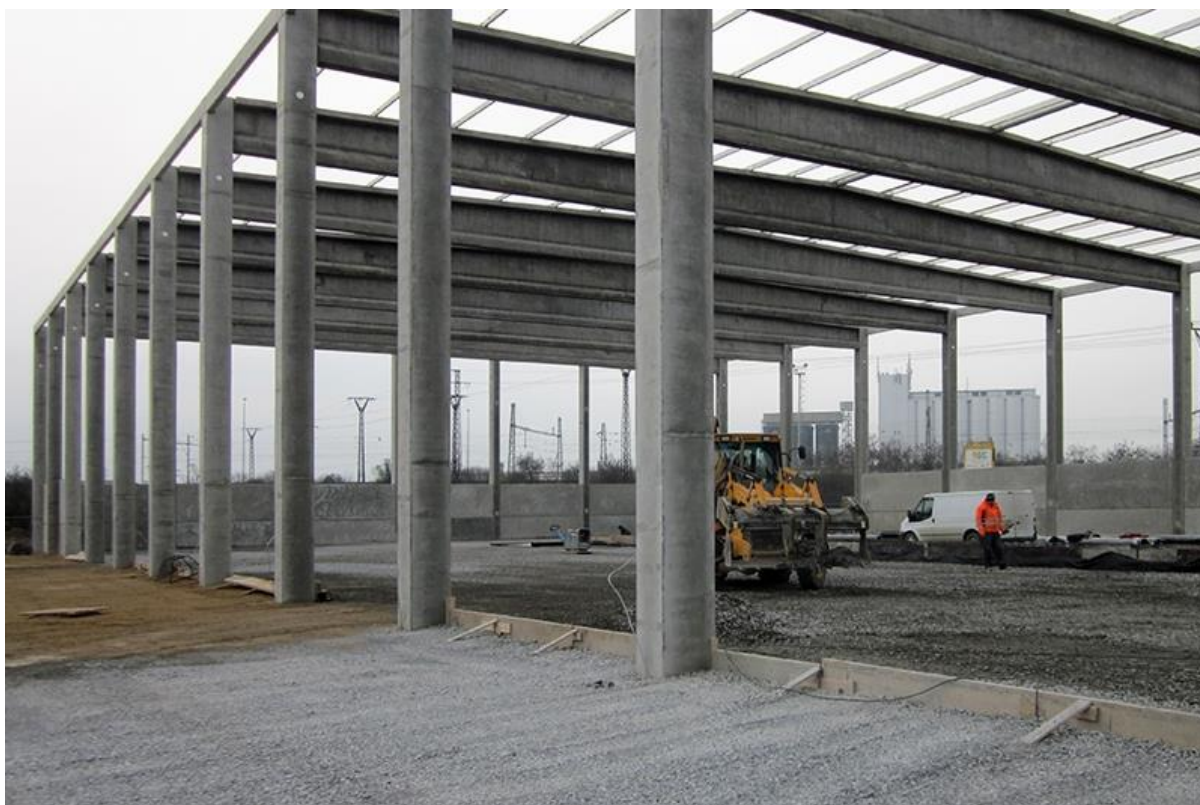
Obrázek 16 – Jednopodlažní hala železobetonového skeletu
