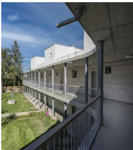
Obr. 2: Bytový dům AKCÍZ
