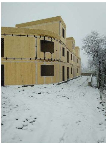
Obr. 1: Výstavba bytového domu
