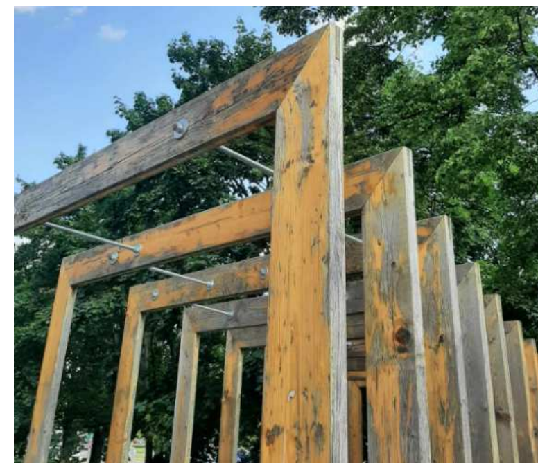
Ocelová ztužující táhla
