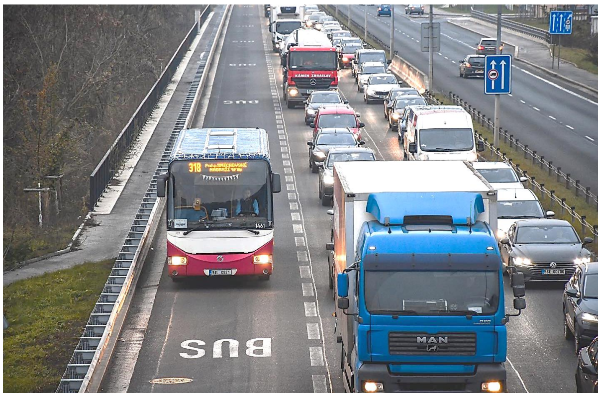
Obr. 1 Příklad preferenčního opatření (vyhrazený jízdní pruh pro autobusy) k rychlému a plynulému průjezdu spojů veřejné dopravy (Praha, ulice Strakonická)
