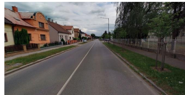
Obrázek 22: Současný stav ulice Pražská [2]
