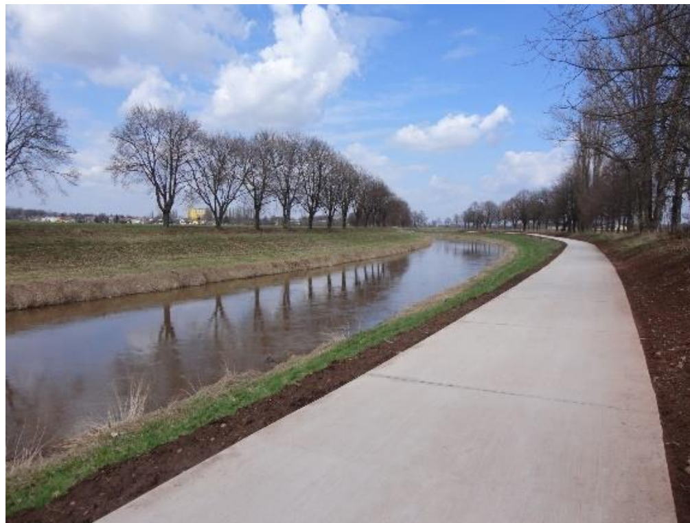
Obrázek 61: Stezka pro cyklisty a chodce s cementobetonovým povrchem [8]
