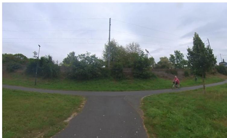
Obrázek 47: Absence vyznačení hlavní a vedlejší komunikace (absence SDZ P 4, resp. VDZ V 6a/b) [22]
