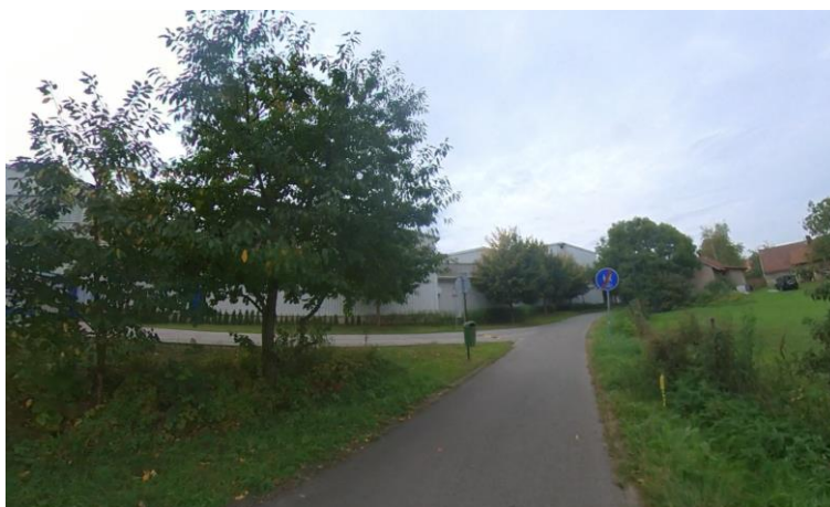
Obrázek 51: Neadekvátní úhel křížení cyklistické trasy 2 u Kostomlátecké ulice, vozidla vyjíždějící z přílehlého průmyslového areálu nemají patřičné rozhledy do pravého směru [22]
