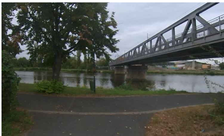
Obrázek 50: Neadekvátní úhel křížení na cyklistické trase 2A pod železničním mostě, cyklisté přijíždějící ve vyobrazeném směru nemají adekvátní rozhled do levého i pravého směru [22]
