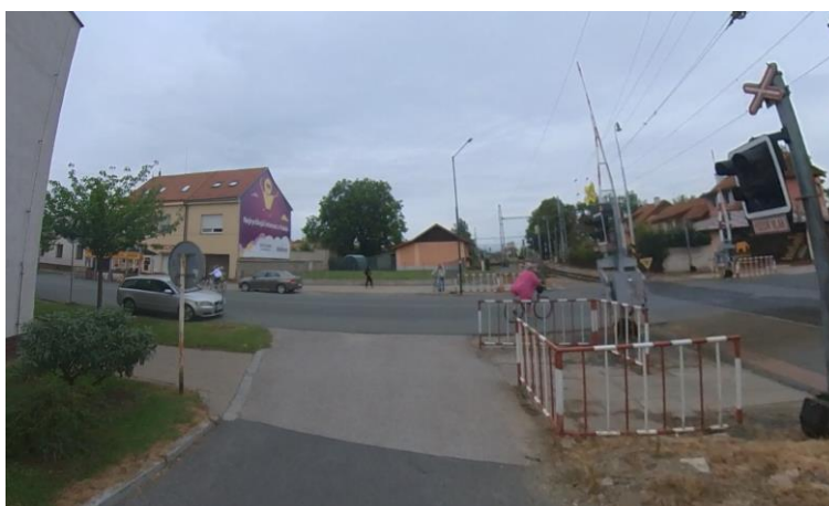
Obrázek 39: Absence návaznosti cyklistické infrastruktury na vyústění stezky pro chodce a cyklisty společné v ulici Tyršova [22]
