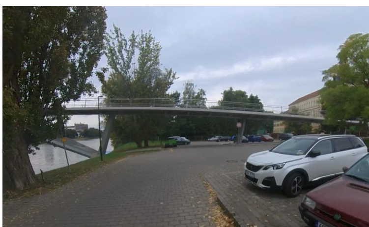
Obrázek 57: Nedostatečná samovysvětlitelnost cyklistické trasy 2 na parkovišti Pod Eliškou [22]
