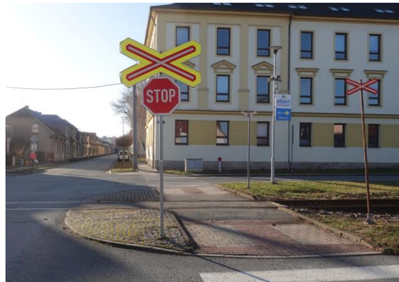
Obrázek 123 – Nevhodná kombinace SDZ s různými světelně-technickými vlastnostmi u železničního přejezdu
