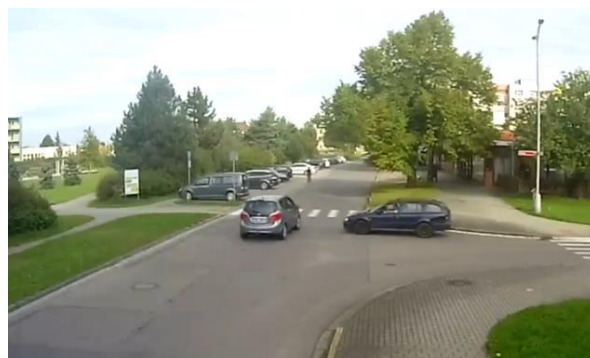
Obrázek 69 – Další pohled na chybné zastavení v důsledku nedostatečných rozhledů
