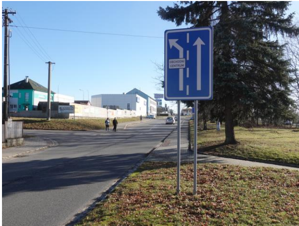
Obrázek 203 – Chybné umístění SDZ IP 19 před řadícími pruhy
