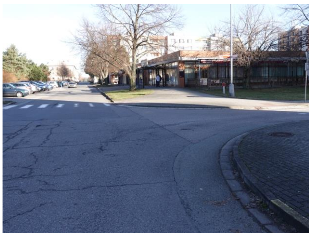
Obrázek 78 – Ukázka absence VDZ V 2b v místě napojení vedlejšího ramene
