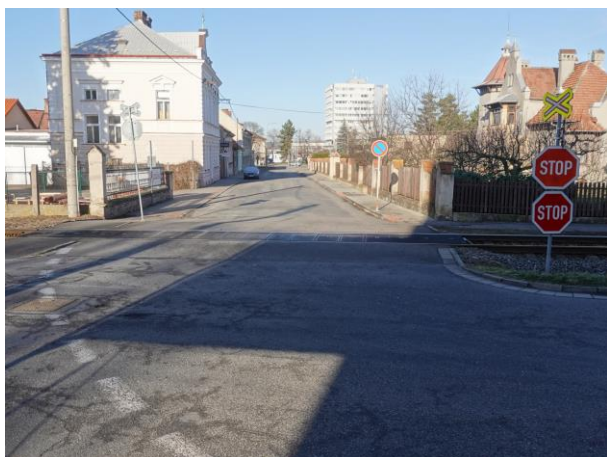
Obrázek 158 – Pohled na železniční přejezd z jižní strany
