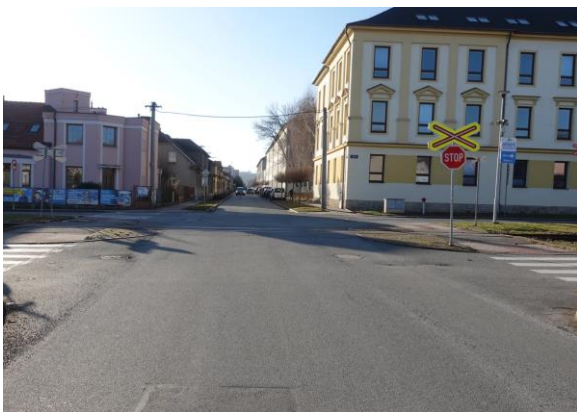
Obrázek 122 – Pohled na sledovanou křižovatku bez realizovaného VDZ vyznačující vedení hlavní komunikace
