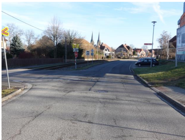
Obrázek 160 – Pohled na místo pro přecházení v západním ramenu
