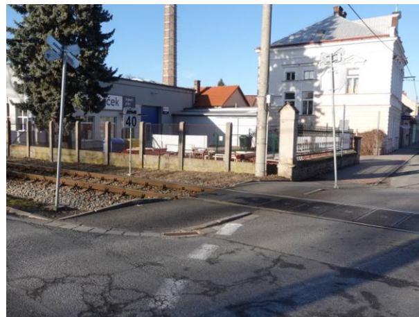
Obrázek 161 – Ukázka železničního přechodu v místě řešené křižovatky
