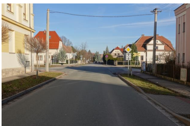
Obrázek 83 – Pohled na průsečnou křižovatku ze západního ramene
