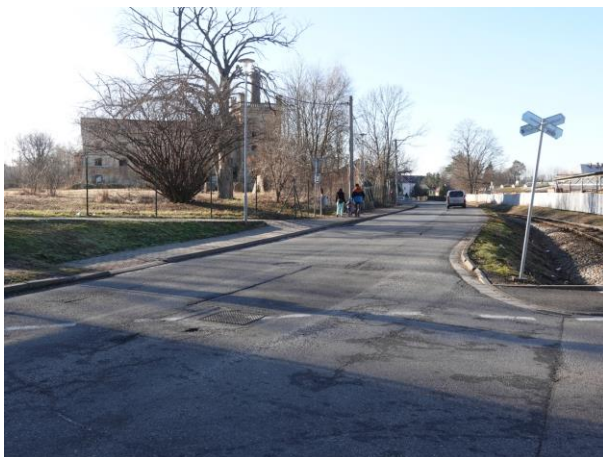
Obrázek 132 – Pohled na přístupové podmínky k místu pro přecházení
