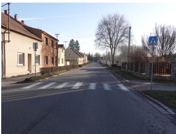
Obrázek 34 – Přechod pro chodce umístěný v jižním ramenu křižovatky
