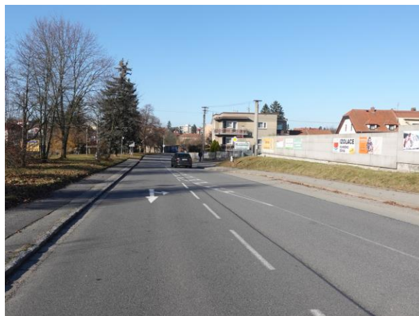
Obrázek 202 – Další pohled na místo častého přecházení chodců
