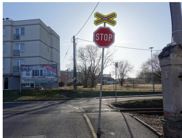
Obrázek 163 – Nevhodná kombinace SDZ s různými světelně-technickými vlastnostmi
