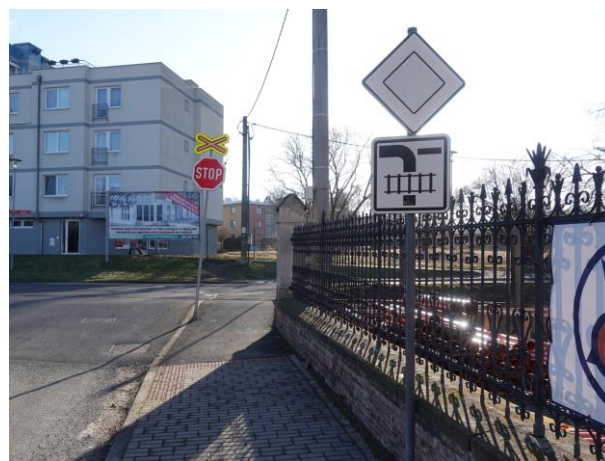
Obrázek 165 – Technicky opotřebované SDZ P 2
