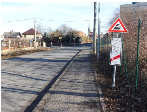
Obrázek 164 – Znečištěné a vyvrácené SDZ
