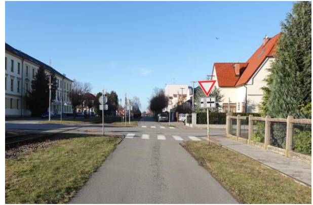
Obrázek 88 – Pohled ze severního ramene východně od železnice do prostoru křižovatky
