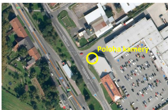
Obrázek 174 – Poloha kamery v místě křížení MK Českých bratří a sjezdu na parkoviště [24]
