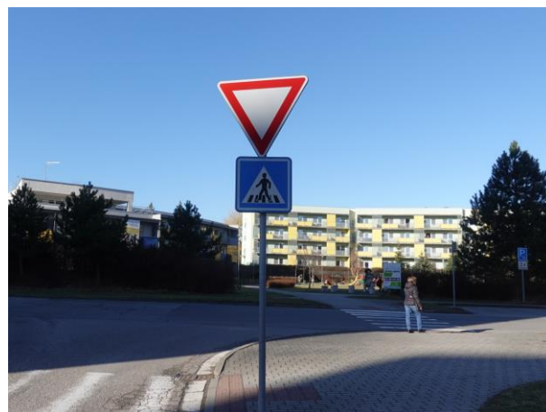
Obrázek 79 – Chybná kombinace SDZ P 4 a IP 6 v místě jižního ramena křižovatky
