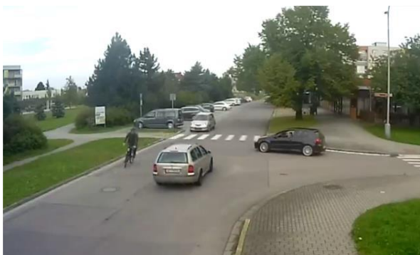
Obrázek 68 – Omezení řidičů na hlavní PK při nájíždění do křižovatky pro zajištění rozhledu
