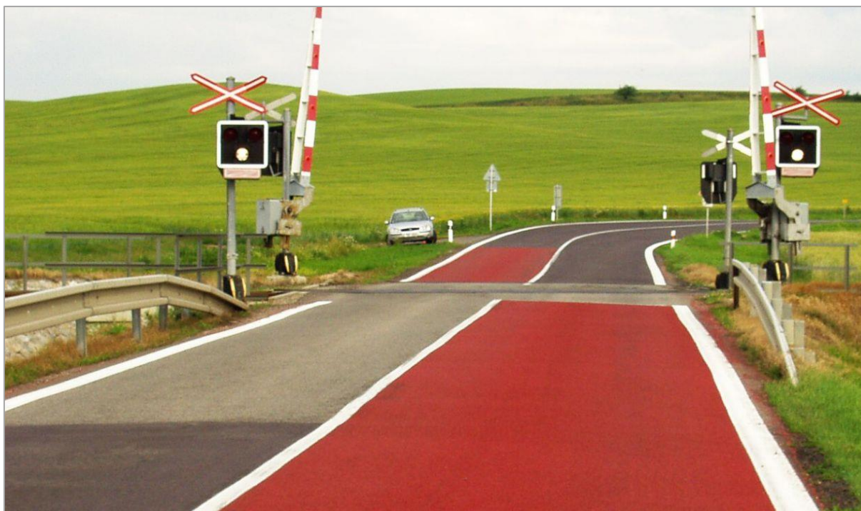
Obrázek 51 – Příklad realizace bezpečnostní protismykové úpravy povrchu vozovky v místě železničního přejezdu (zdroj: [92])
