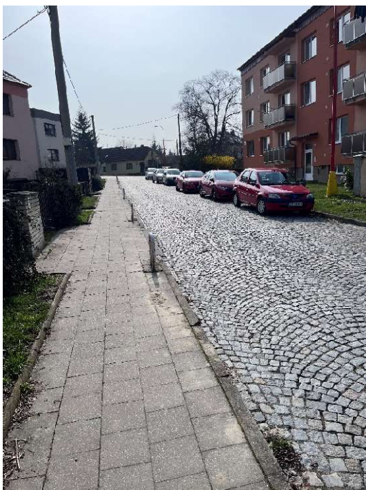
Obrázek 23 kovové zábrany v ulici K Cihelně [foto autor]
