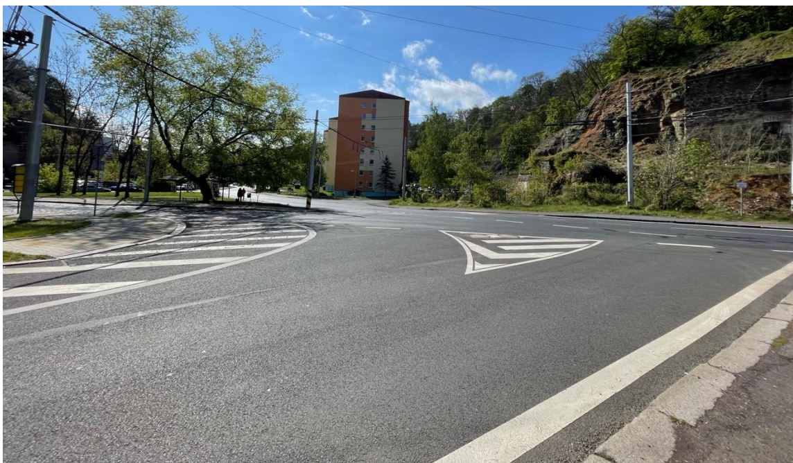
Obrázek 39 – Pohled na křižovatku ulic U Kamenných lázní – U Hadích lázní (zdroj: autor)
