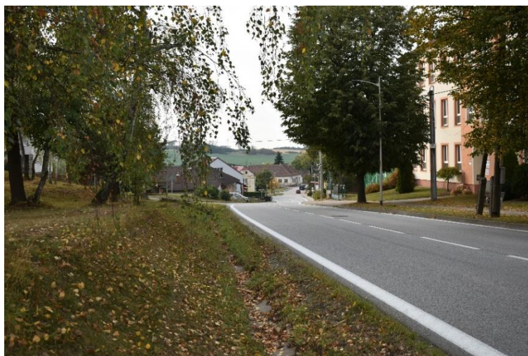
Obrázek 7 - Fotografie současného stavu I/23 v obci Předín – pohled směr ZÚ (zdroj: vlastní)
