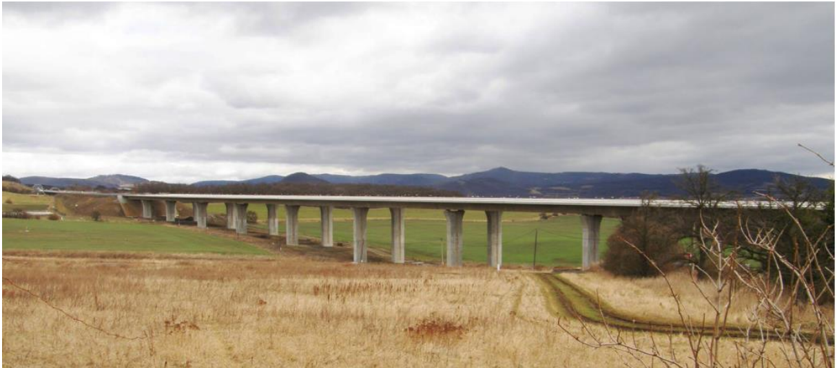
Obrázek 11 - Most o více polích - typ 6 (zdroj: Katalog mostů (03/2020), ŘSD)
