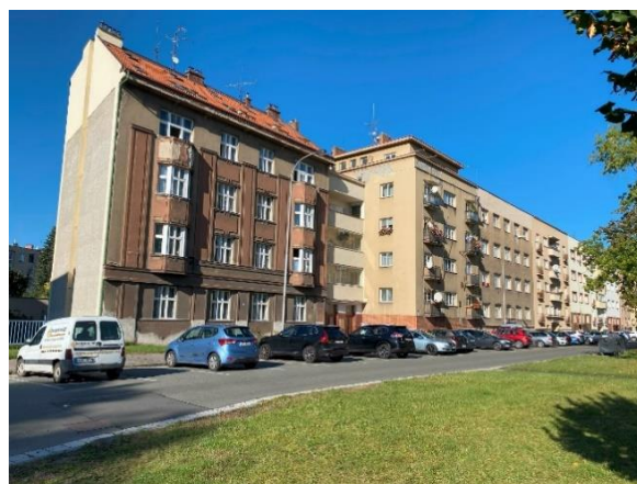
Obrázek 16 Činžovní dům na severní straně pozemku – Foto autor
