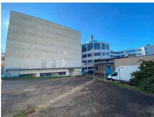
Obrázek 17 Novákovy garáže a Palace office vyfocené z parcely řešeného projektu – Foto autor
