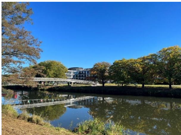
Obrázek 18 Nová lávka a centrála ČSOB – Foto autor
