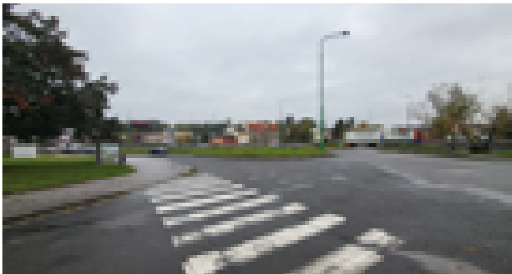
KŘÍŽOVATKA „U TESCA“ OD TYRŠOVA MOSTU
