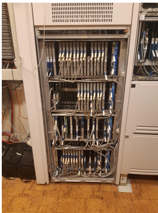
Obrázek 3.3: Pohled pod ochranný kryt ústředny MD-110 z brněnského zařízení
