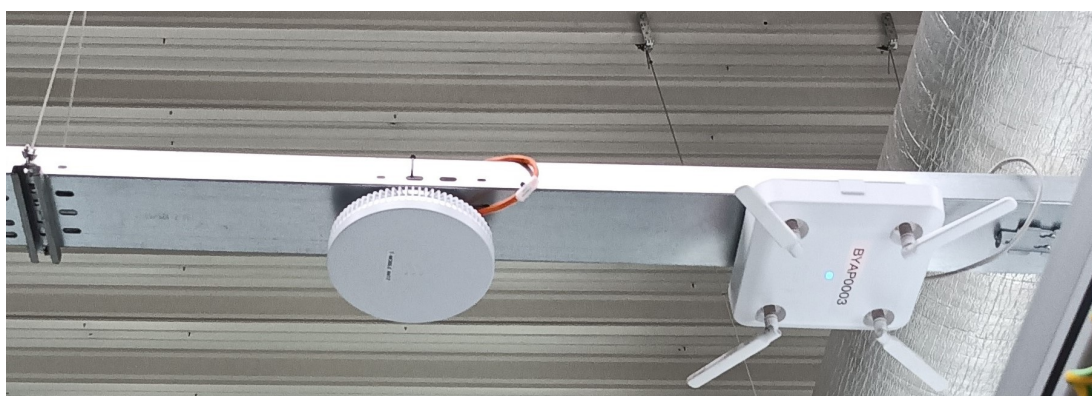
Obrázek 6.5: Radio Dot (vlevo) umístěný vedle Wi-Fi modemu (vpravo).
