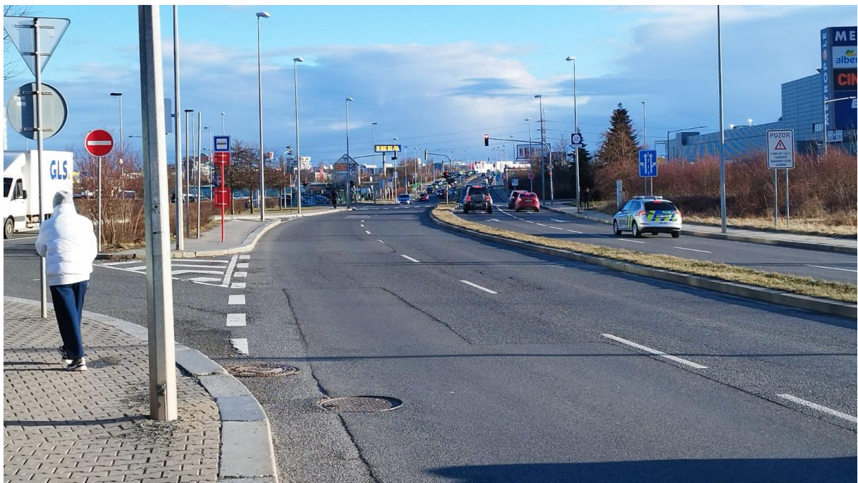
Obrázek 11 - Pohled na Řevnickou ulici od ulice Na Radosti
