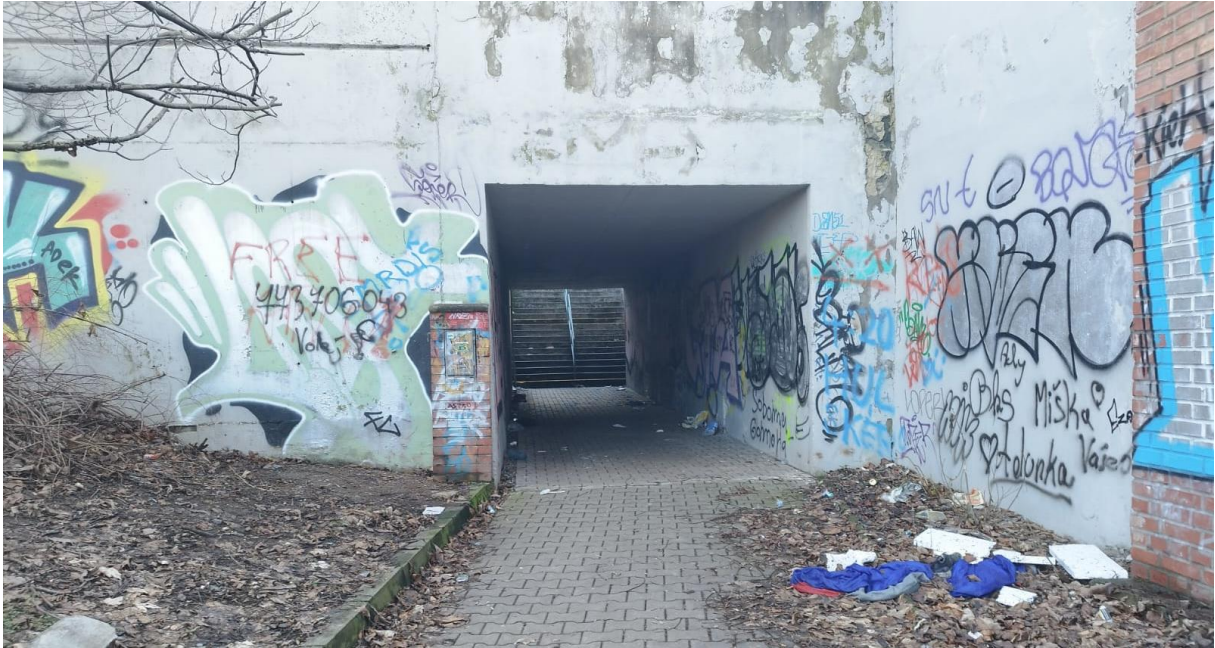
Obrázek 19 - Podchod pod zkušební tratí metra
