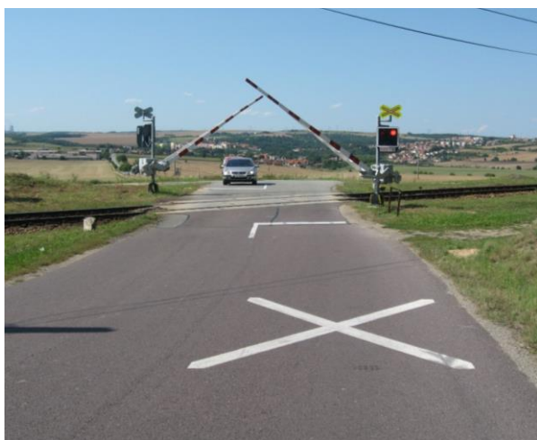
Obrázek 10: Vodorovné dopravní značení V 15, nápis na vozovce, se symbolem svislé značky A 32a [14]
