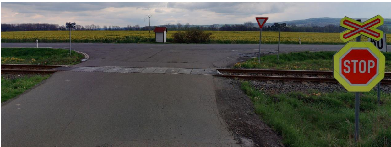
Obrázek 12: Přejezd P7812 za nímž bezprostředně leží úrovněová silniční křižovatka s povinností dání přednosti v jízdě [45]
