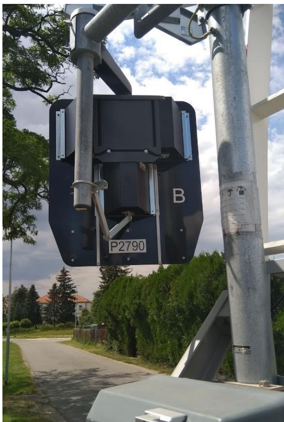
Obrázek 5: Způsob umístění čísla na přejezdu s PZS [autor]
