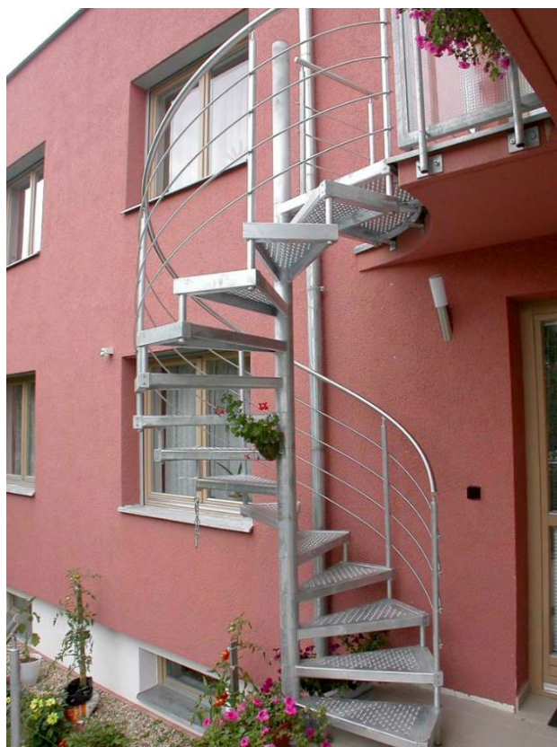
Obrázek 10 - Realizace exteriérového schodiště[15]
