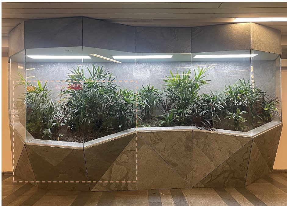
Obrázek 36 Čelní pohled na Metrorost a vyznačená část kde dochází k plesnivění
